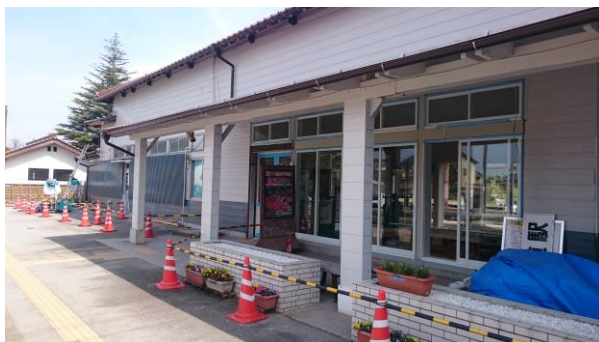
JR宍道駅改修中！
