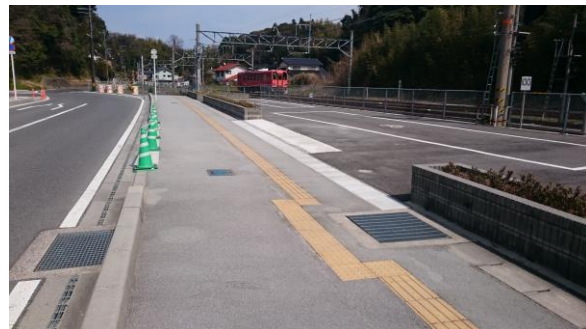
大型バス待機場 完成！
