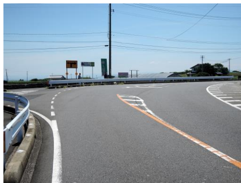
▲ 終点側(馬渡市道三差路)より起点側を望む
