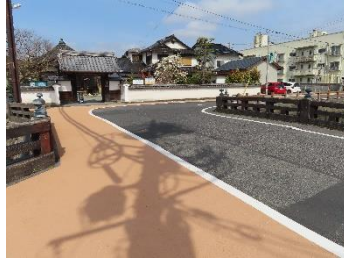
区画線工、薄層カラー舗装 (北田町~母衣町)
