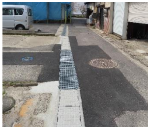
側溝の整備、道路舗装 (南田町)
