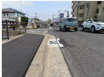
歩道舗装、集水樹設置 (学園南)
